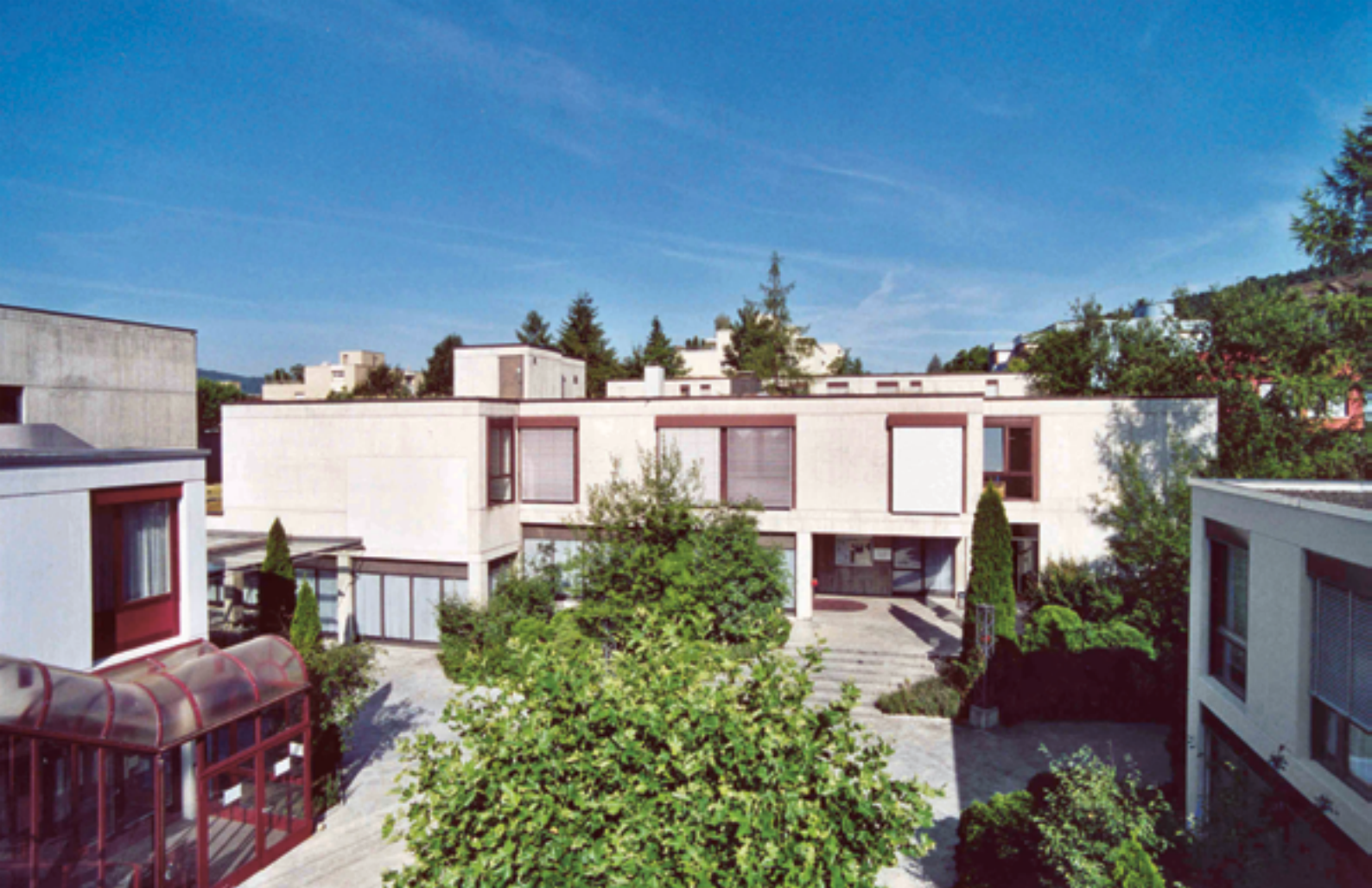
GE Zentrum Aussenansicht, Reformierte Kirche Weiningen
